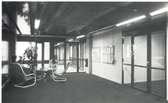
Överst: Frisørsalong i Kista Centrum, Stockholm. Ugnslackerade stålpartier i Cewe 40-konstruktion.
